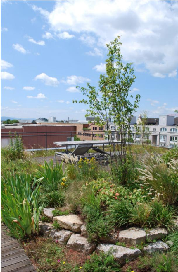
Prämiertes Objekt in Karlsruhe. Nach einer Sanierung zum begehbaren Biodiversitätsgründach ausgebildet. Mit Steinmauer und höheren Substratbereichen mit Gehölzen
