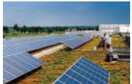
6. Das fertig begrünte Dach mit Solaranlage.
