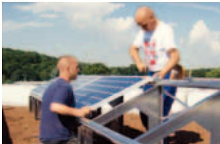
5. Die Solarmodule werden montiert.
